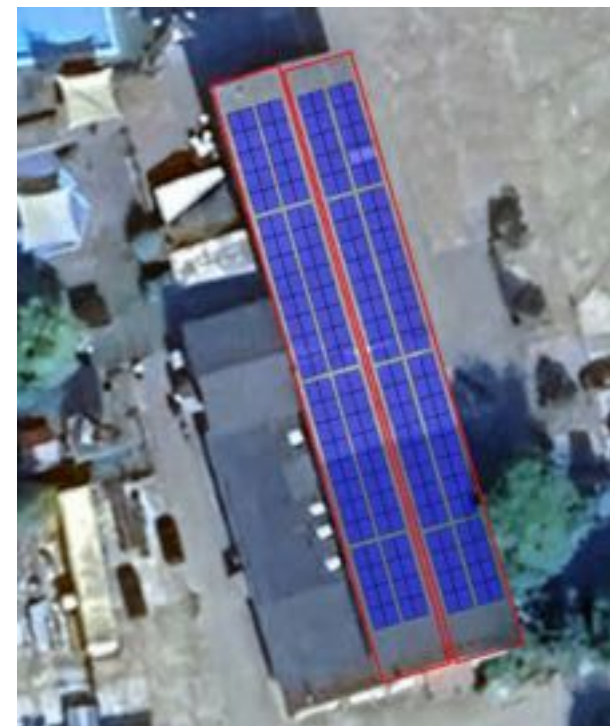
Sanierung / Umnutzung – 98 kWp
