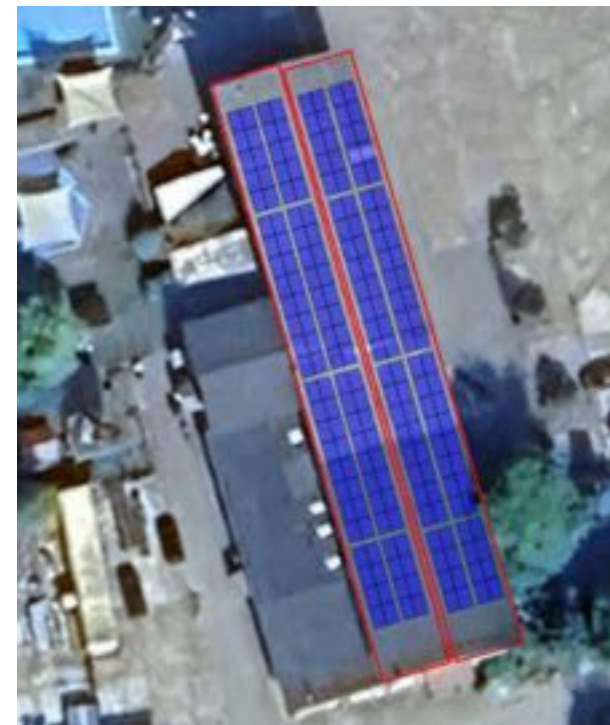
Sanierung / Umnutzung – 98 kWp
